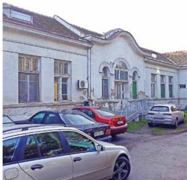
Zgrada Psihijatrije pre rekonstrukcije
