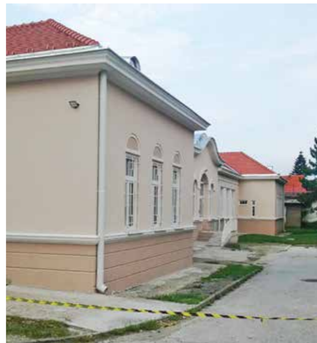
Zgrada Psihijatrije posle rekonstrukcije
